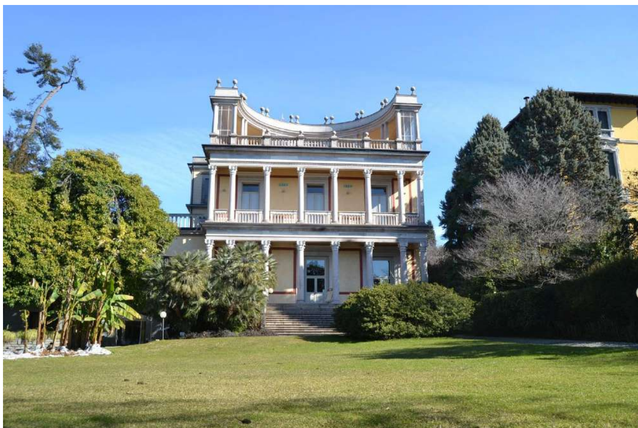
Esterno e giardino
